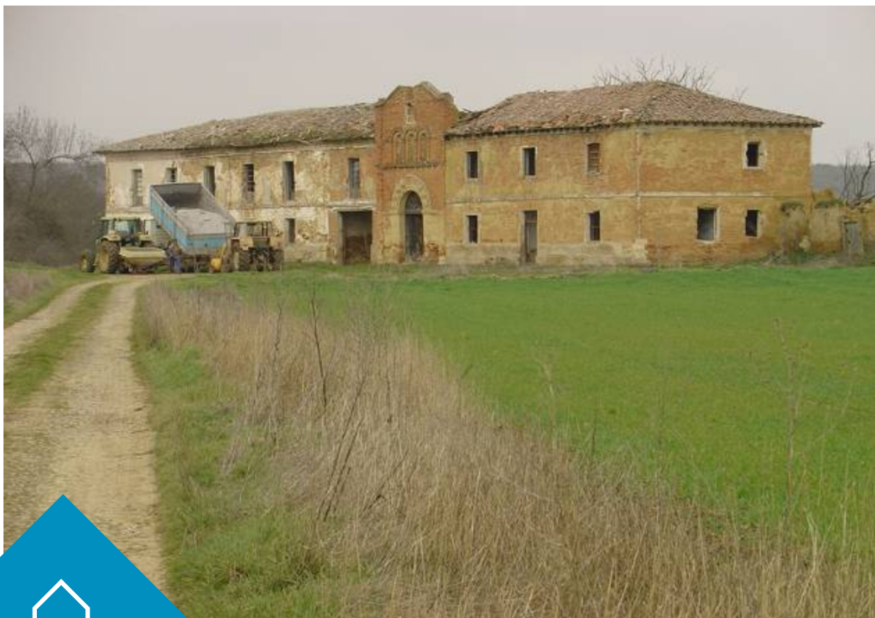
Antiguo hospital de Santa María de las Tiendas, antes de su demolición ocurrida hace unos pocos años
