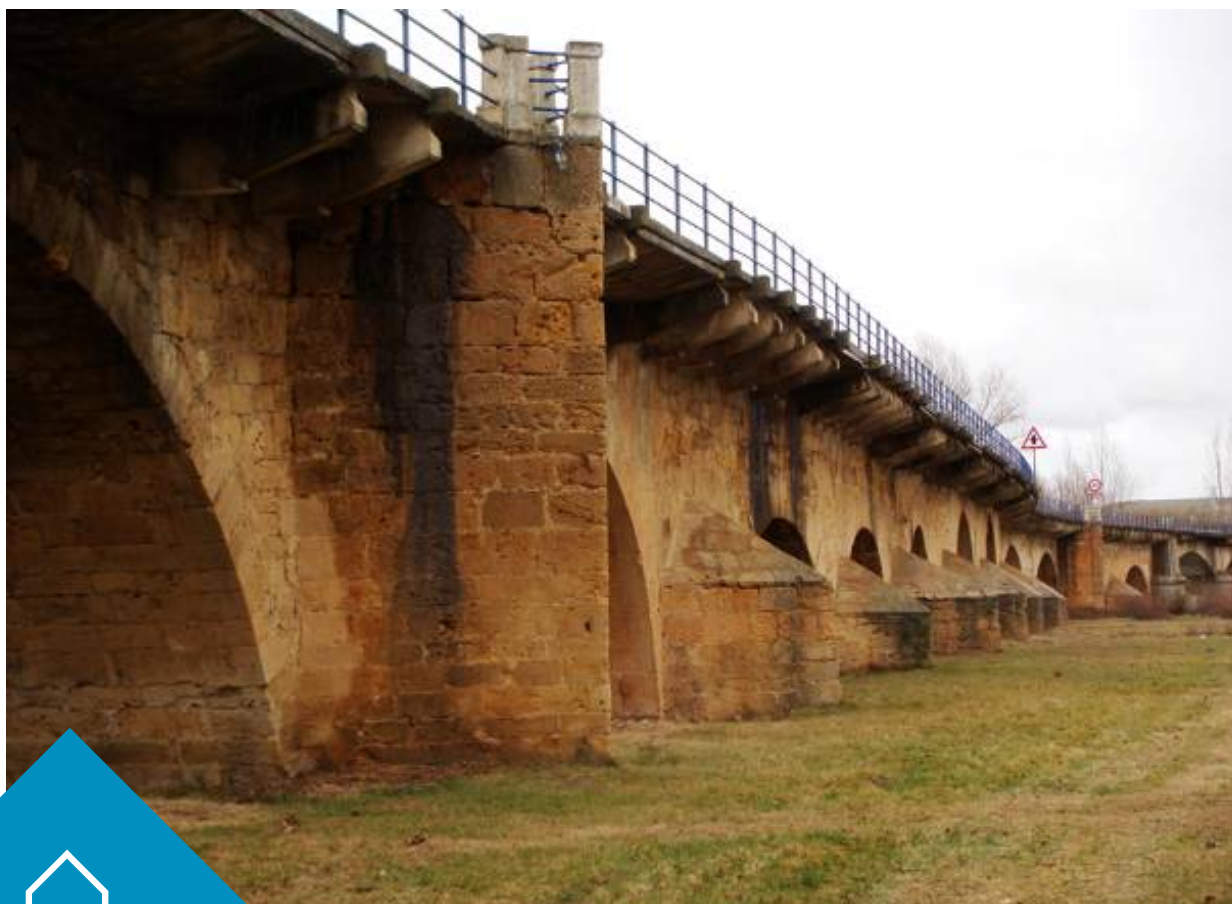
Puente de Villarente
